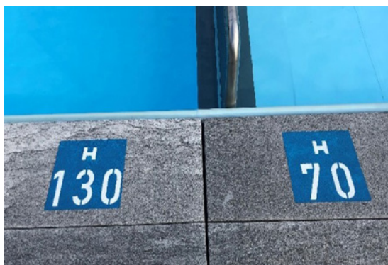
Illustration 7: Signalisation des profondeurs d'eau au bord d'un bassin
