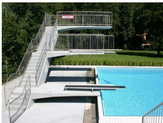
Illustration 32: Garde-corps dans une installation de plongeon
